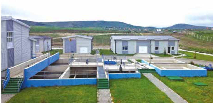
Slika 2: Vrhnji del kemičnih bazenov, v katerih se nadzorovano dodaja kemikalije, kot sta klor in natrijev hipoklorid.
