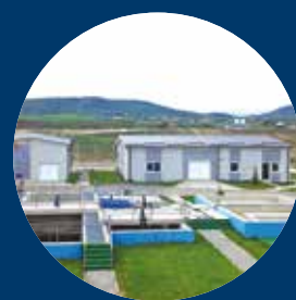
IZGRADNJA VODARNE ZA REGIJO VUSHTRII
