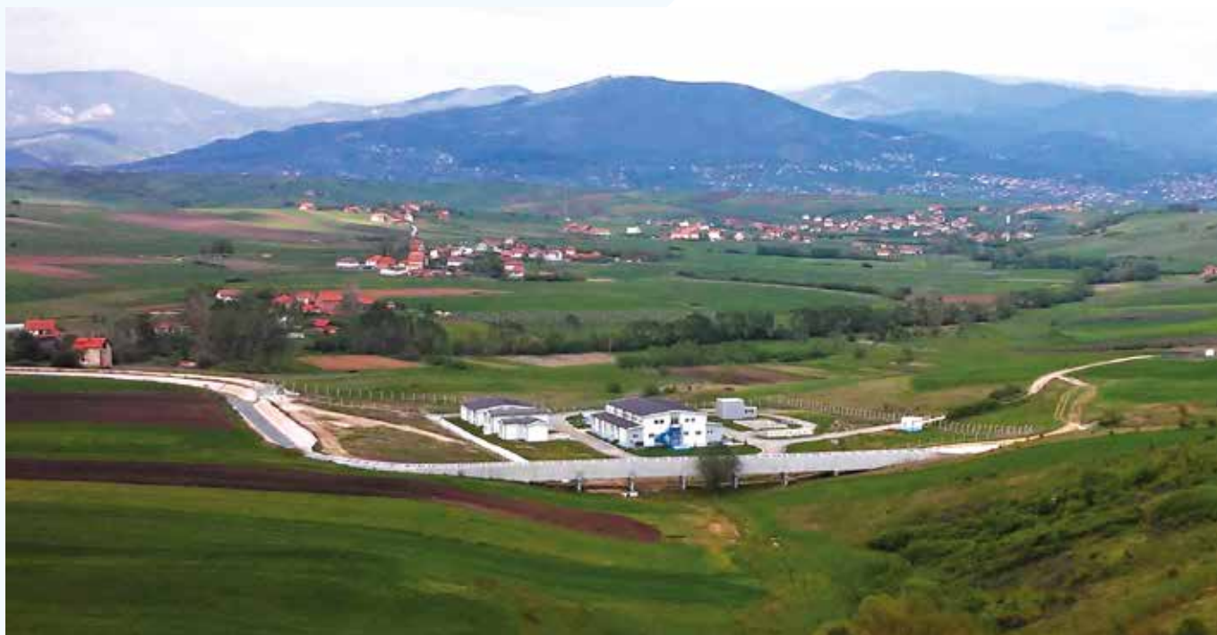
Slika 1: Pogled na vodarno z bazena "Elevated tank". Viden je kanal Ibar, ki napaja vodarno ter nadaljuje svojo pot proti Prištini.
