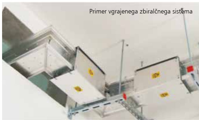
Priključek transformatorja
