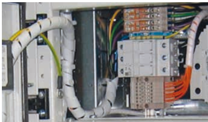
Slika 1 – Vezava tokovnih sponk in varovalk
