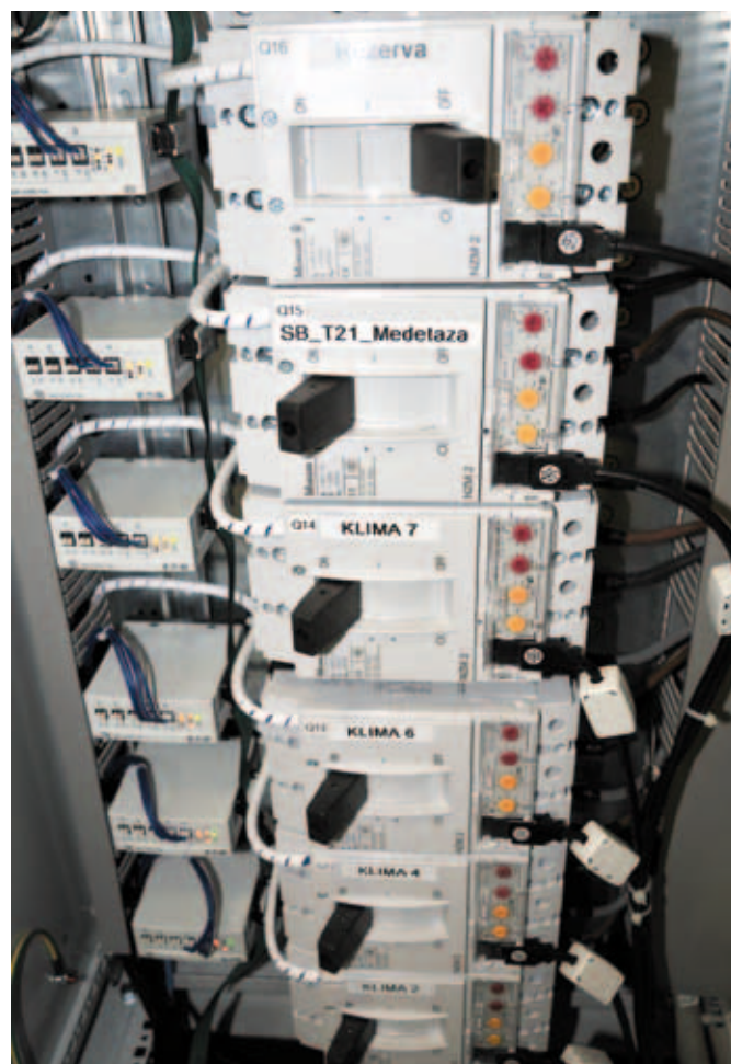
Sliki 1 in 2 – Sodoben kompaktni odklopnik NZM v kombinaciji s krmilnim ožičenjem SmartWire-DT
