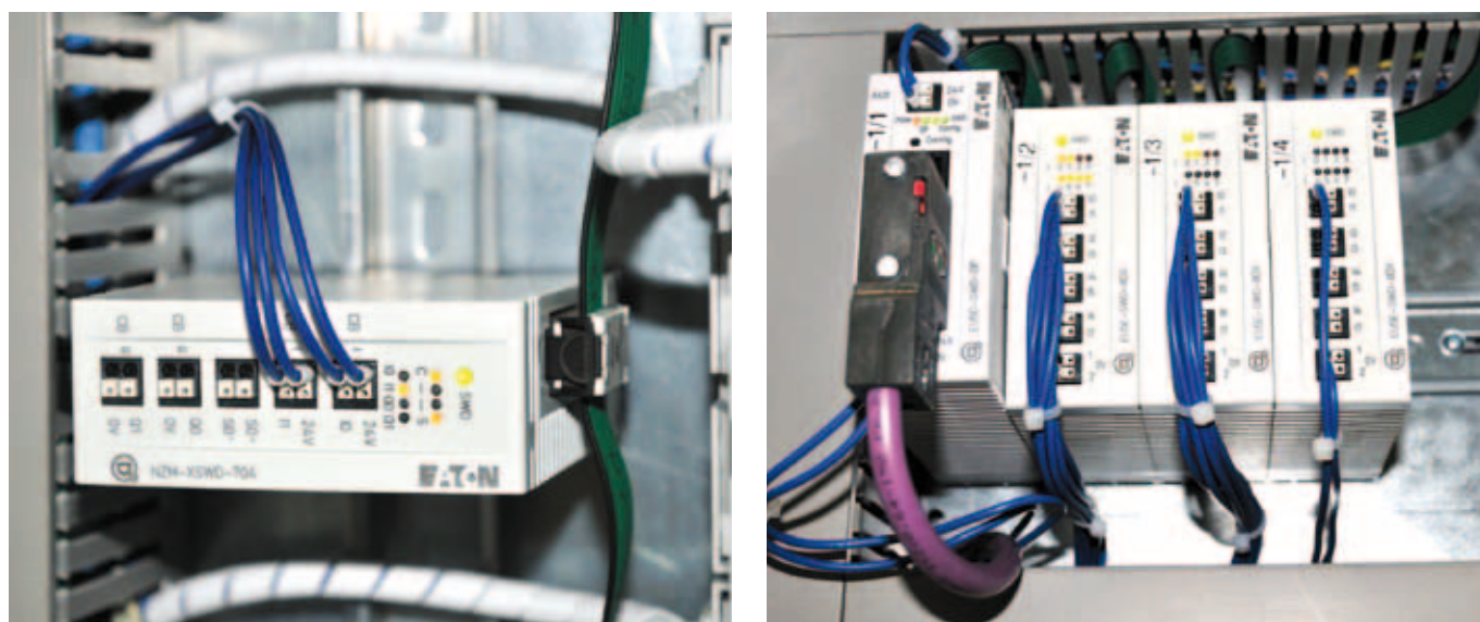
Sliki 5 in 6 – Gradniki krmilnega ožičenja: levo komunikacijski modul NZM-XSWD-704, desno komunikacijski vmesnik SmartWire-DT/Profibus in digitalni vhodni modul EU5E-SWD-8XD
