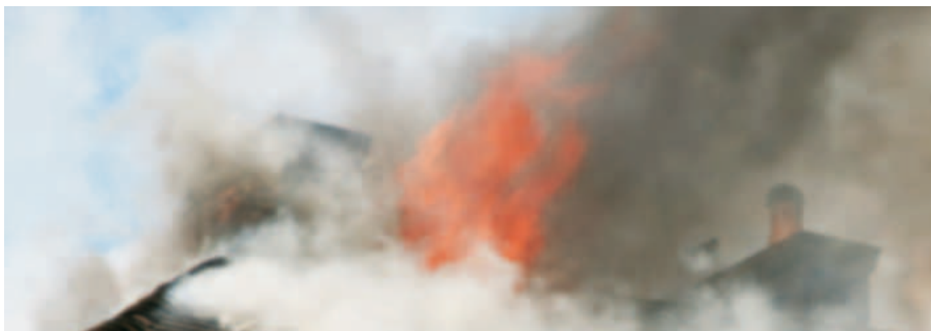
Slika 1 – Požar na stavbi s fotonapetostno elektrarno
