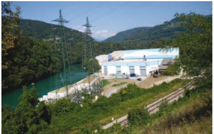
Slika 1 – Črpalna hidroelektrarna Avče
