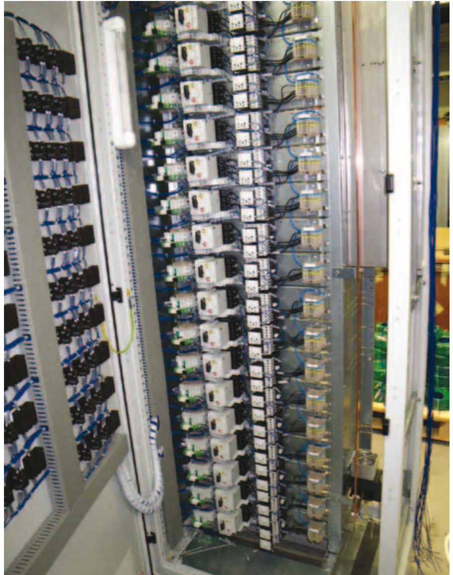
Slika 3 – Odcepi manjših moči, izvedeni s PKZ2
