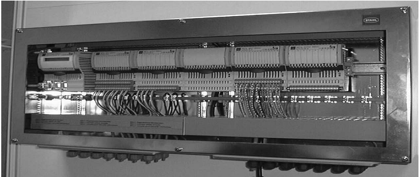
Slika 2 - Ohišje z vgrajenimi moduli I.S.1
